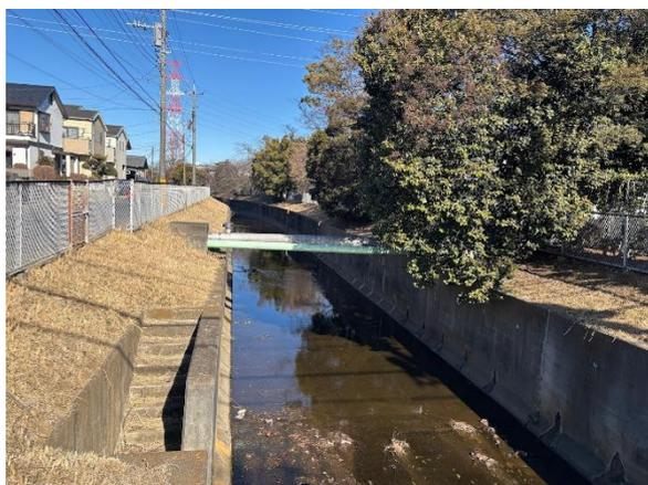
写真1 コンクリート3面張り護岸
