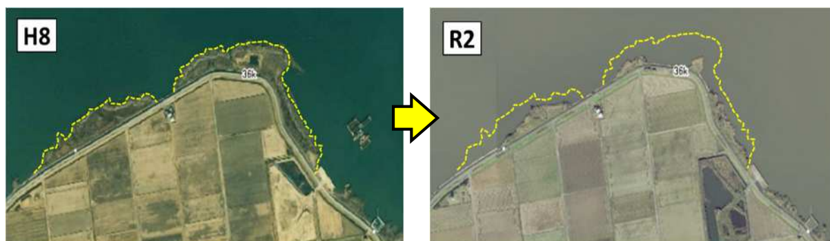
(写真) 湖岸植生帯の減少状況 (西浦右岸36km付近)
