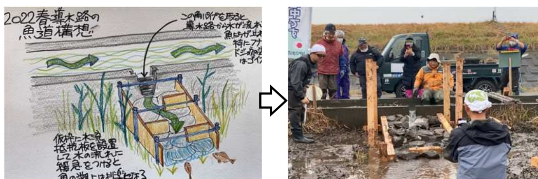
(写真) 魚道構想と実際に設置した魚道
