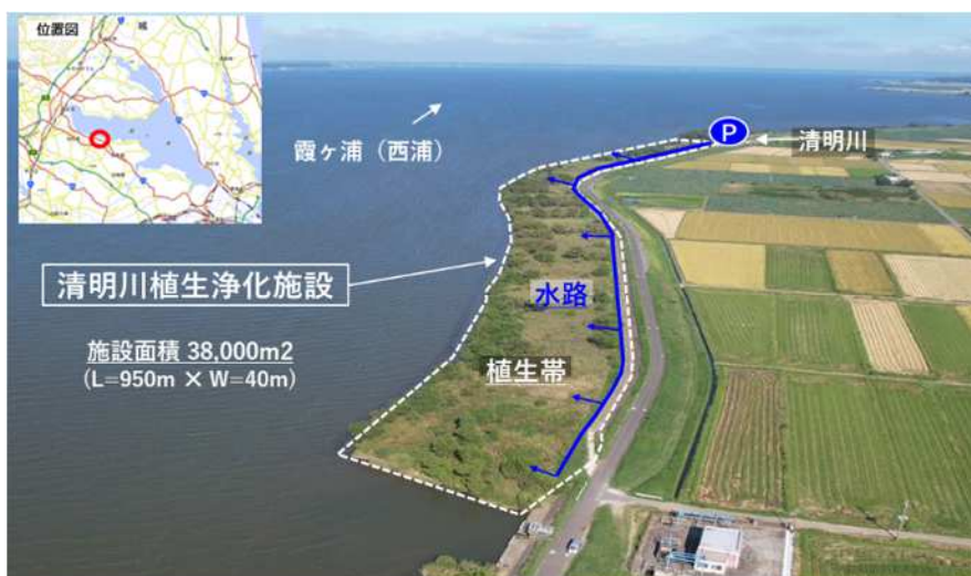
(写真) 清明川植生浄化施設全景
